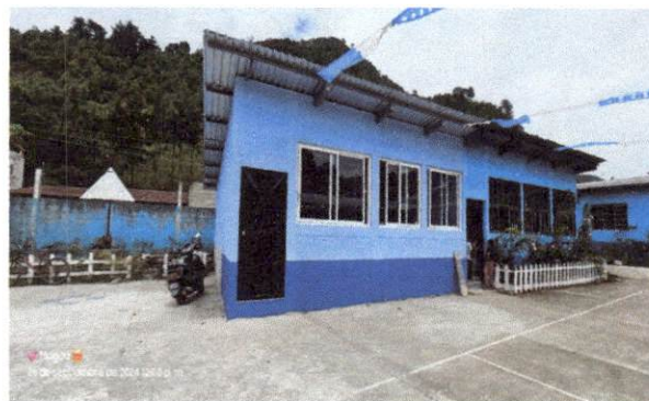
Foto 4: finalizacion de modulo tipo fortico
