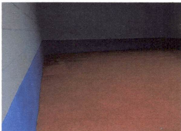
Foto1: finalizacion de piso
