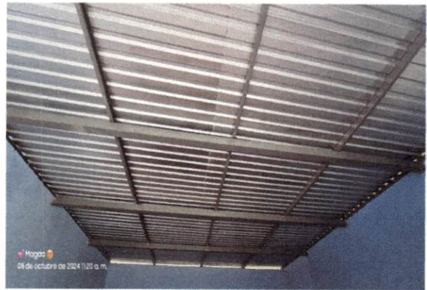
Foto 2: techo de cocina finalizado
