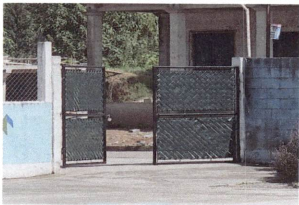
Foto 3: finalizacion de privacinta
