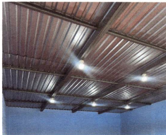
Foto 2: finalizacion de estructura metalica y techado troquelado
