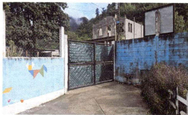
Foto 4: finalizacion de porton
